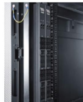
**Блоки распределения питания (БРП)** в шкафах «широкой» серии могут ориентироваться при установке как вдоль боковой стенки (стандарт zero-unit), так и поперек. Поперечная установка 3х-фазных БРП глубиной до 140 мм позволяет использовать порты без помех оборудованию 19".
