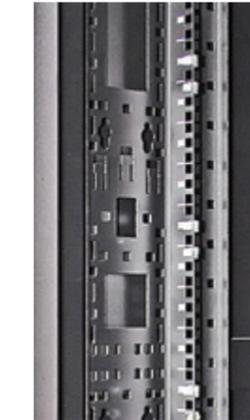
Передняя и задняя сварные рамы соединены **зубатками**, на которые зацепами крепятся вертикальные компоненты. Установочная позиция по глубине задается зубчатой гранью с шагом 7 мм, и закрепляется фиксатором на вертикальном компоненте. В число этих компонентов входят 2 **монтажных лотка**, оснащенных перфорацией и вырезами для установки БРП и укладки кабеля.
